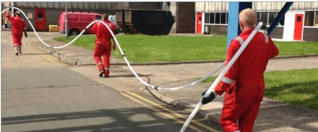
Neunzehn 7-Kanal-CMT-Systeme wurden in einer Produktionsanlage zur Charakterisierung und Überwachung einer Schadstofffahne unter dem Gebäude, die vom Standort abwandert, installiert. Die Systeme wurden mittels Sonic Drill in 30m Tiefe eingebaut. Anspruchsvolle Geologie gestaltete das Bohren und den Einbau schwierig, aber alle Systeme wurden in zwei Wochen installiert.
